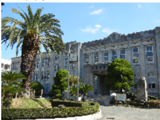
福岡県有形文化財の校舎（築86年）
